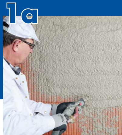
1a Násřík jádrové vysoce lehčené / tepelně-izolační omítky s vlákny.
