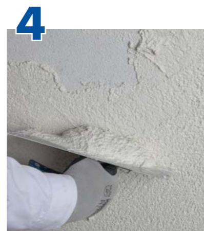
4 Nanesení šlechtěné tenkovrstvé omítky ve zvolené zrnitosti a probarvené do požadovaného odstínu.
