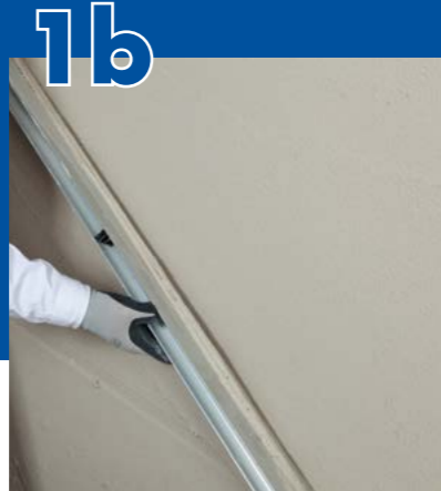
1b Srovnání omítkové vrstvy trapézovou latí.
