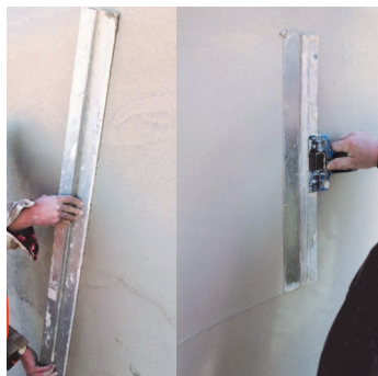
Obr.2 Urovnání povrchu "h-latí" a fasádní špachtlí.
