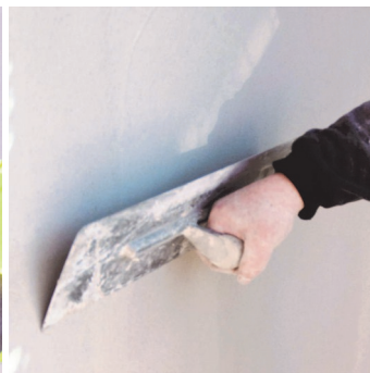
Obr.4 Navlhčení povrchu a vyhlazení nerezovým hladítkem příp. ještě dohlazení fasádní špachtlí.
