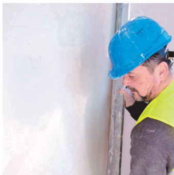
Obr.3 Po zatuhnutí stržení povrchu "v-latí" a odvodušnění stržením kolmo postavenou fasádní špachtlí.
