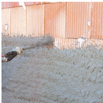
Obr.1 Nástřik omítky pomocí omítačky.
