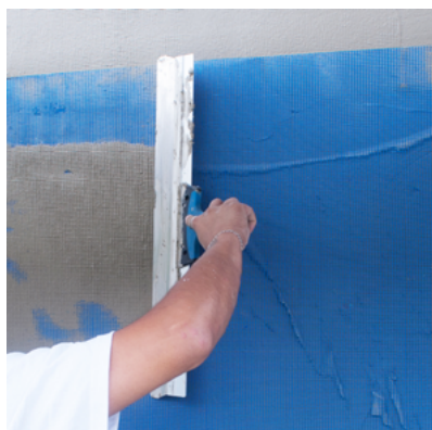
5. Vložení armovací tkaniny a její zatlačení a vyhlazení povrchu fasádní špachtlí
